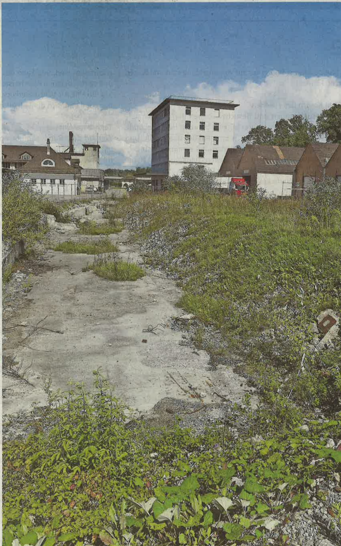
Weg damit: Die alten Fabrikhallen will die Grundeigentümerin Lorze Logistik AG abreißen lassen. Darunter auch die frühere Malerei (vorne links im Bild), die als erhaltenswert eingestuft wird.
